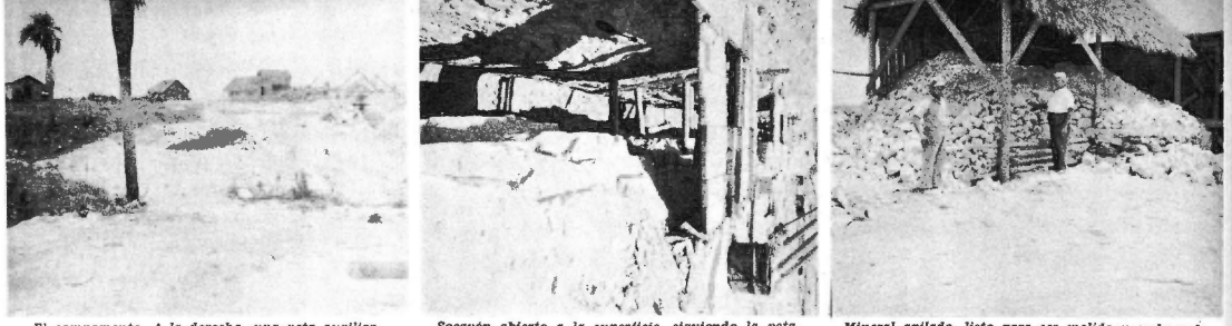
El campamento. A la derecha, una veta auxiliar.
